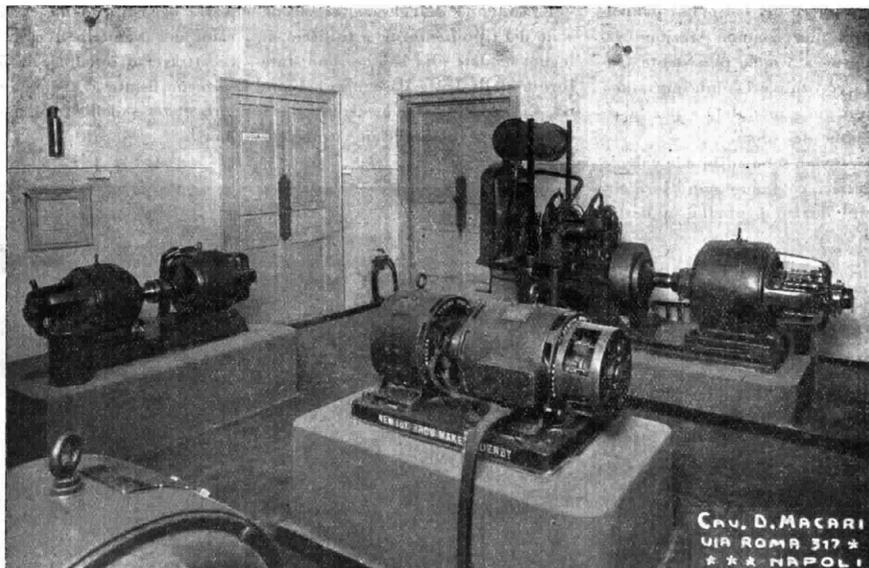
Fig. 7. - Sala macchine con gruppo elettrogeno di riserva
