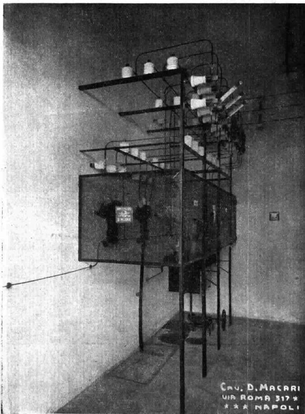
Fig. 6. - Particolare della cabina di trasformazione
