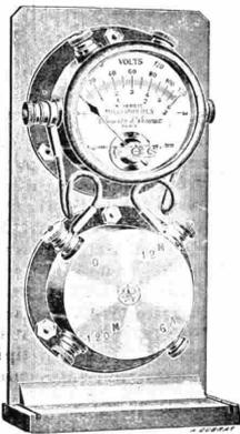
Cassetta di controllo TSF 185x95x50 m/m.terna 3-12-120 milliamper 6 Amp. Il tutto è racchiuso in una elegante scatola di legno sul coperchio della quale sono segnati per facilitarne l'uso schemi e istruzioni. E' un vero laboratorio per dilettanti.
