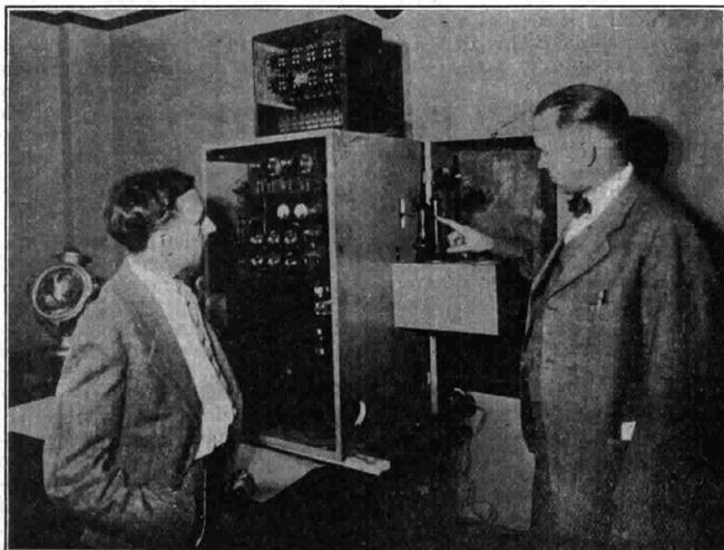
Ecco il nuovo apparecchio denominato «Televox» col quale è possibile azionare a distanza, mediante comandi a voce, qualsiasi dispositivo elettromeccanico.
