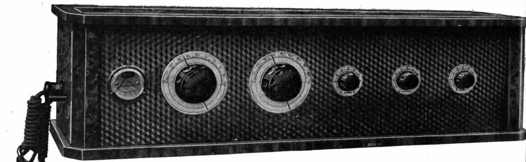
Realizzazione di un apparecchio ricevente in supereterodina a 7 valvole, montato in bigiglia per onde da 250 a 3000 metri.
