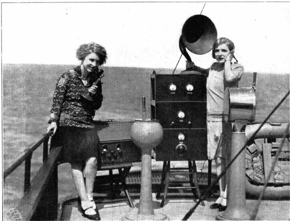
**ATTUALITÀ RADIOTELEFONICHE AMERICANE** — Ecco una completa installazione trasmettente-ricevente radiotelefonica, montata su un «yack» da diporto che permette ai passeggeri di questo di scambiare conversazioni con persone nelle proprie abitazioni in terraferma
