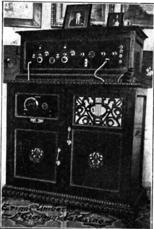
1) Supereterodina - 2) Amplificatore A. F. neutralizzato - 3) Altoparlante - 4) Batterie accumulatori
