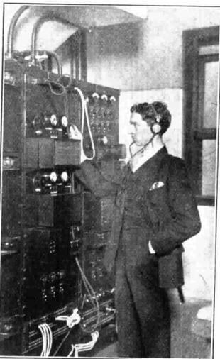
Nei principali alberghi americani sono stati installati degli impianti radiofonici muniti di speciali amplificatori di potenza capaci di alimentare più di 2000 altoparlanti distribuiti nelle varie camere.
