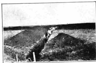
Santa Palomba (Roma) Scavi per la posa del sistema di terra
