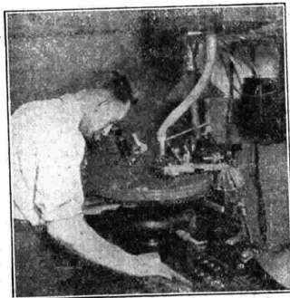
Come avviene l'incisione delle vibrazioni sonore su disco di cera nel sistema «Viatphone».
