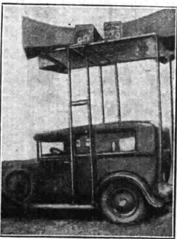
Il sistema di amplificazione per i discorsi pubblici reso portatile con l'uso di una automobile.
