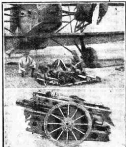
Un cannone tipo Howitzer smontato ed un montato, pronto per essere trasportato in aeroplano.
