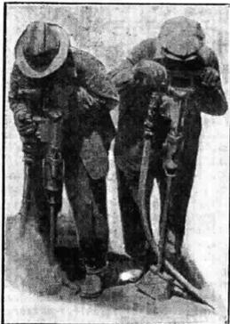
Due perforatrici in funzione delle quali quella di destra è fornita dell'apparecchio che assorbe la polvere.
