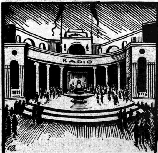
Ingresso al padiglione Radio.
