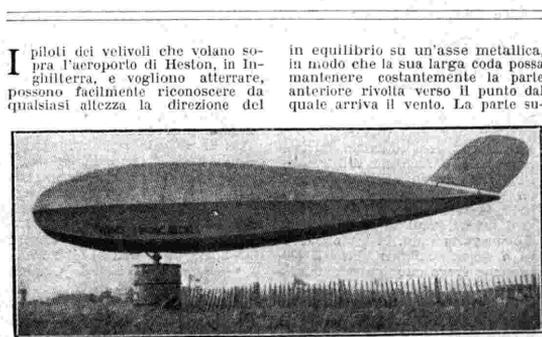
vento che spirava sul campo di atterraggio, osservando il gigantesco apparecchio di segnalazione che vi è stato recentemente impiantato. Trattasi di un indicatore per il vento della forma di un dirigibile, montato
