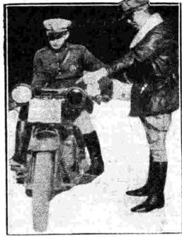
a portata di mano di chi se ne serve. La corrente per il funzionamento dell'apparecchio ricevente viene fornita o dal motorino o da quattro accumulatori che si trovano in due borsette poste sotto il sedile. I risultati ottenuti nei primi esperimenti, tanto durante la corsa che con la motocicletta ferma, fanno sperare nell'utilità pratica di questo nuovo ricevitore, che può riuscire comodissimo per la comunicazione di ordini agli agenti in servizio.
