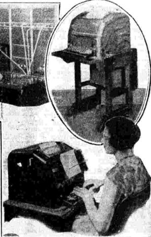
macchina, in modo che chi chiama si accerti se abbia ottenuto il numero esatto. Finita la comunicazione, l'abbonato che ha chiamato per primo fa un segnale speciale, sempre con la macchina da scrivere, che interrompe la comunicazione, fermando i motori elettrici di tutti e due gli abbonati, ed accende la lampadina di controllo della signorina addetta al centralino, in modo che essa possa togliere la spina,
