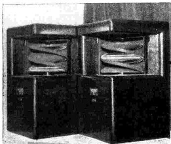
Ricevitori di tipo meccanico, a proiezione su speciale di specchi (finezza d'analisi 90 e 120 linee).
