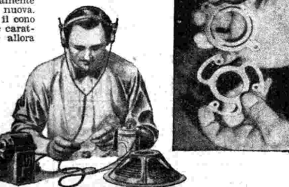
1. Con una striscia di carta si può individuare il punto di contatto tra la bobina mobile e il magnete. — 2. Con una pila a secco e una cuffia è facile riconoscere se una bobina è interrotta. — 3. Alcuni modelli di sistemi centranti.
