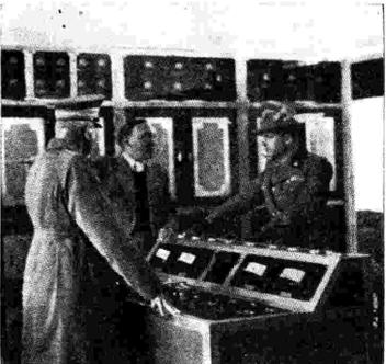
Una installazione in « duplex » di speciali stazioncine ad onda corta ed ultra corta assicurano una completa riserva nei collegamenti telefonici con la sede di Bolzano in caso di interruzione dei circuiti in cavo.
