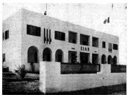
L'edificio del trasmettitore.
