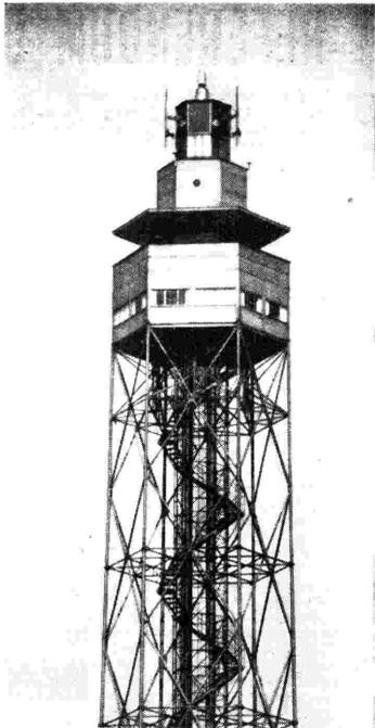
Le antenne trasmettenti di radiovisione in sommità della torre Littoria di Milano. — Lanterna «video» è unica al centro; le antenne del suono sono tre, ugualmente distanziate e provviste di specchio riflettore.
