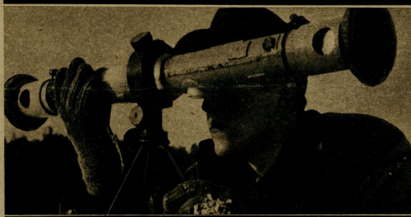
3. Un apparecchio misuratore delle distanze per l'addestramento dei volontari in montagna (Foto Presse Illustrationen)
