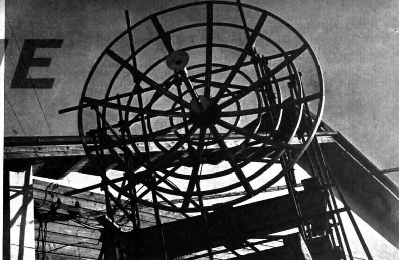
Paraboloide ricevente a M. Penice del collegamento a microonde con Milano e Torino
