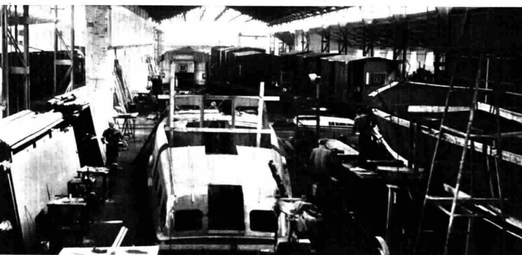
L'attività dei cantieri navali siciliani è molto notevole. Nella foto, uno dei cantieri di Messina
