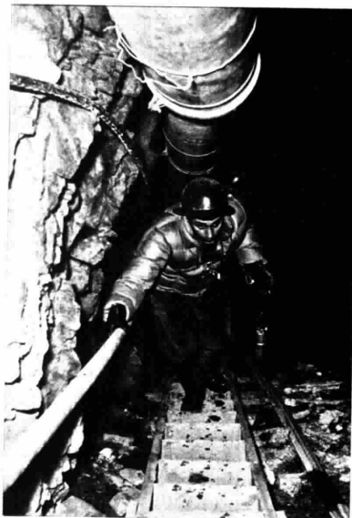
Uno dei due imbocchi che conducono al fronte di avanzamento. Lungo la volta corre la condotta dell'impianto di ventilazione necessario ad eliminare dall'atmosfera i residui tossici delle esplosioni
