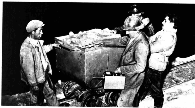
Un Geiger-Müller in funzione. L'ago del microamperometro segna «radiazione massima». Buon segno. Il contatore di Geiger-Müller è uno strumento indispensabile per le ricerche di uranio. E' in grado infatti di rivelare esattamente impulsi dell'ordine di un milionesimo di secondo provocati dalle radiazioni gamma emesse dal minerale
