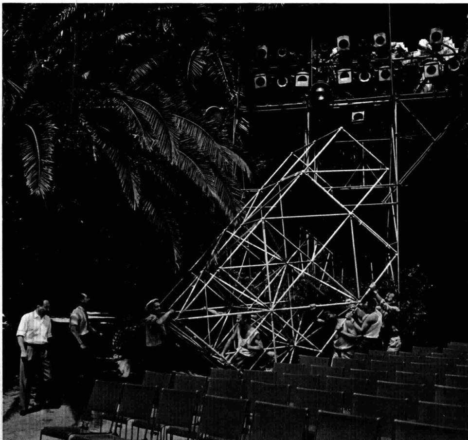
Piazzato un gruppo di proiettori per la ripresa notturna si procede all'erezione di una torre metallica per la postazione di una telecamera
