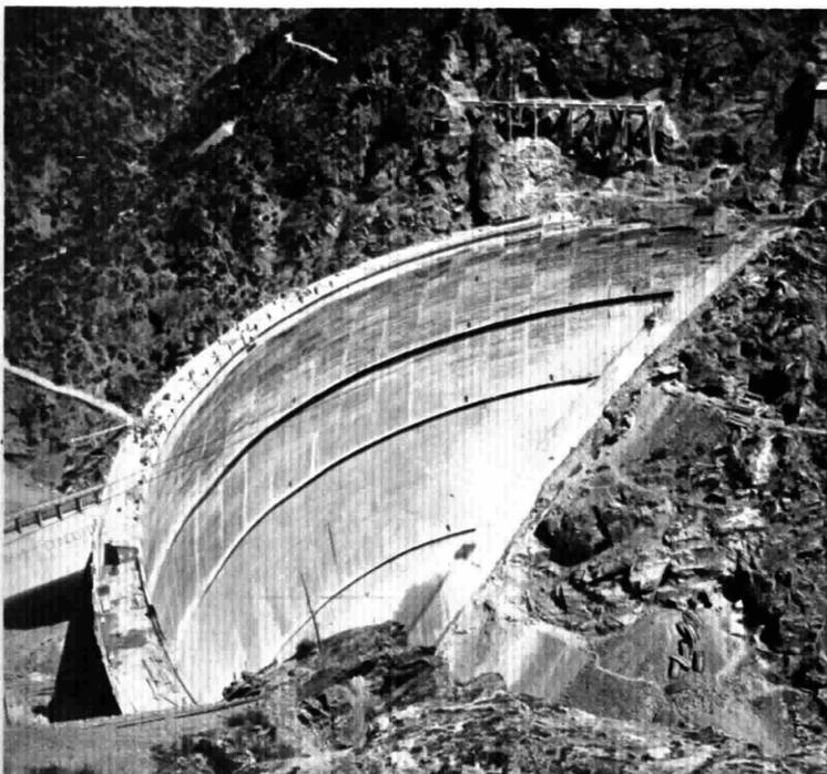
La diga del Flumendosa, in questo bacino si riverseranno con la prossima stagione delle piogge milioni e milioni di metri cubi di acqua che fino a ieri fluivano completamente inutilizzabili nel mare Tirreno. L'acqua sarà deviata verso il bacino del Campidano da una galleria di adduzione
