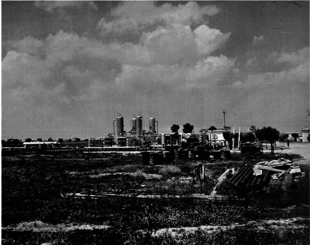
Dintorni di Comacchio: gli impianti dei pozzi di trivellazione
