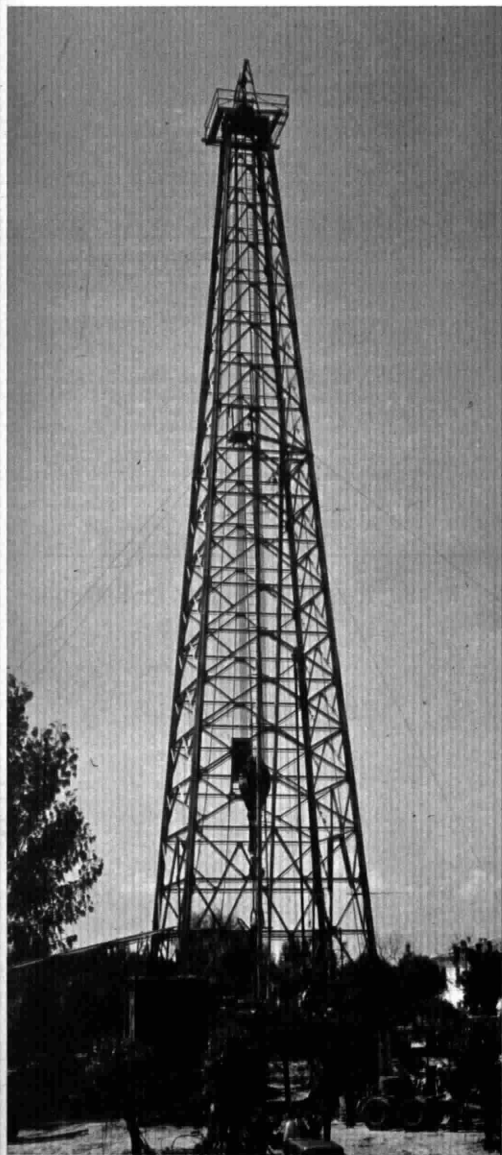
Una torre di trivellazione per ricerche nel sottosuolo di Comacchio
