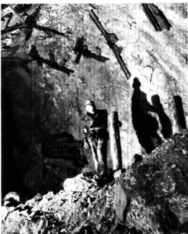
Cantiere XI Aloisi Nord a Cave del Predil (Udine) - Moderni sistemi di armatura della roccia mediante imbullonamento
