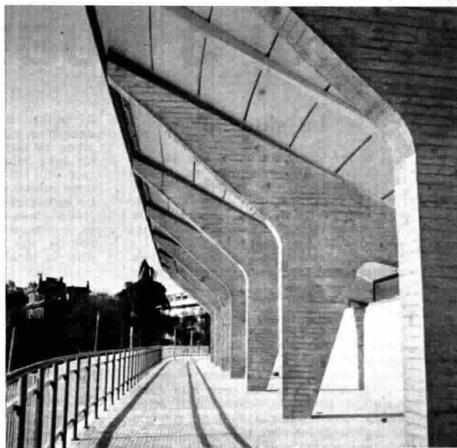
La curva delle gradinate, con un angolo della tribuna. Tutte le gradinate, e la copertura della tribuna, sono state fatte con elementi prefabbricati. A destra: uno scorcio delle strutture portanti, tipiche dello stile di Nervi. Queste strutture hanno permesso lo sbalzo esterno delle gradinate, raddoppiando la capienza dello stadio pur su un'area uguale a quella dello stadio precedente
