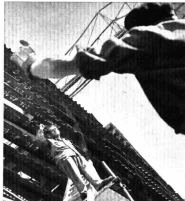
L'impostazione di una nave oggi è puramente formale. Quando il primo pannello viene montato sullo scafo gran parte della nave ha già visto la luce ed attende il suo turno di montaggio
