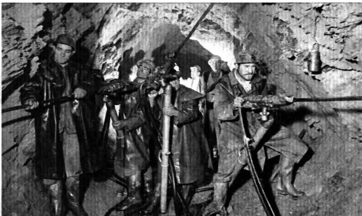
Progressiva 873. Con i perforatori Tigre i minatori dell'avanzamento si aprono un varco nella roccia del San Bernardo. I lavori per la costruzione del traforo, iniziati l'1 dicembre 1959, saranno conclusi nella primavera del 1961. Il tunnel si svilupperà per una lunghezza di 5.853 metri
