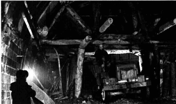
Un dumper carico di detriti fa la spola ogni quarto d'ora fra il fronte d'avanzamento e l'uscita. Finora dalle viscere del San Bernardo è stata estratta una « carota » di 50.000 metri cubi di roccia. Quando sarà ultimato il getto del calcestruzzo verranno rimosse le armature di legno
