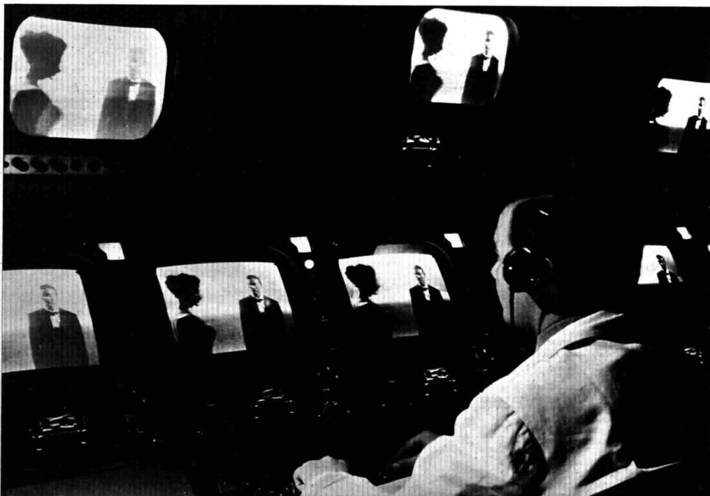
La sala controllo video. E' installata in un locale adiacente alla cabina regia. Il tecnico siede davanti agli schermi del «monitor» ed al «rack», singolari armadi metallici punteggiati di valvole termioniche e di spinotti per chiudere i circuiti
