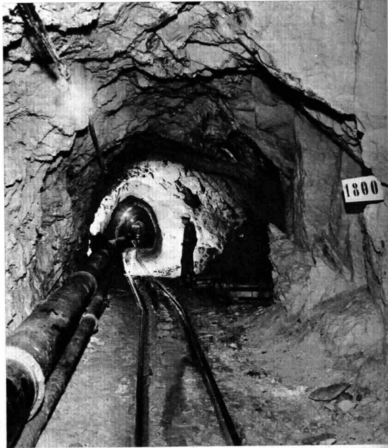
Ecco uno stretto cunicolo di avanzamento sul versante italiano. In questi budelli rocciosi i minatori hanno condotto la lenta battaglia di penetrazione. Sulla sinistra le provvisorie condotte per il ricambio dell'aria. Il traforo sarà aperto al traffico entro il 1963
