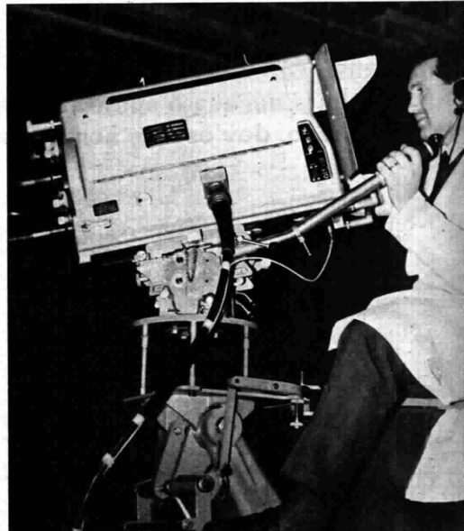
Il cameraman alla telecamera: la mano sinistra impugna il «braccio di panoramica», che serve per i rapidi spostamenti in senso azimutale; l'occhio è attento al mirino, la cuffia porta all'orecchio le voci dei tecnici del controllo video, che osservano e correggono continuamente l'immagine
