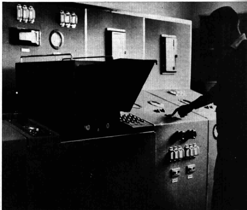
Al centro del banco, il monitor attraverso il quale l'operatore può seguire, stando al sicuro, tutte le fasi dell'impasto della dinamite. L'innovazione è stata introdotta nel 1953
