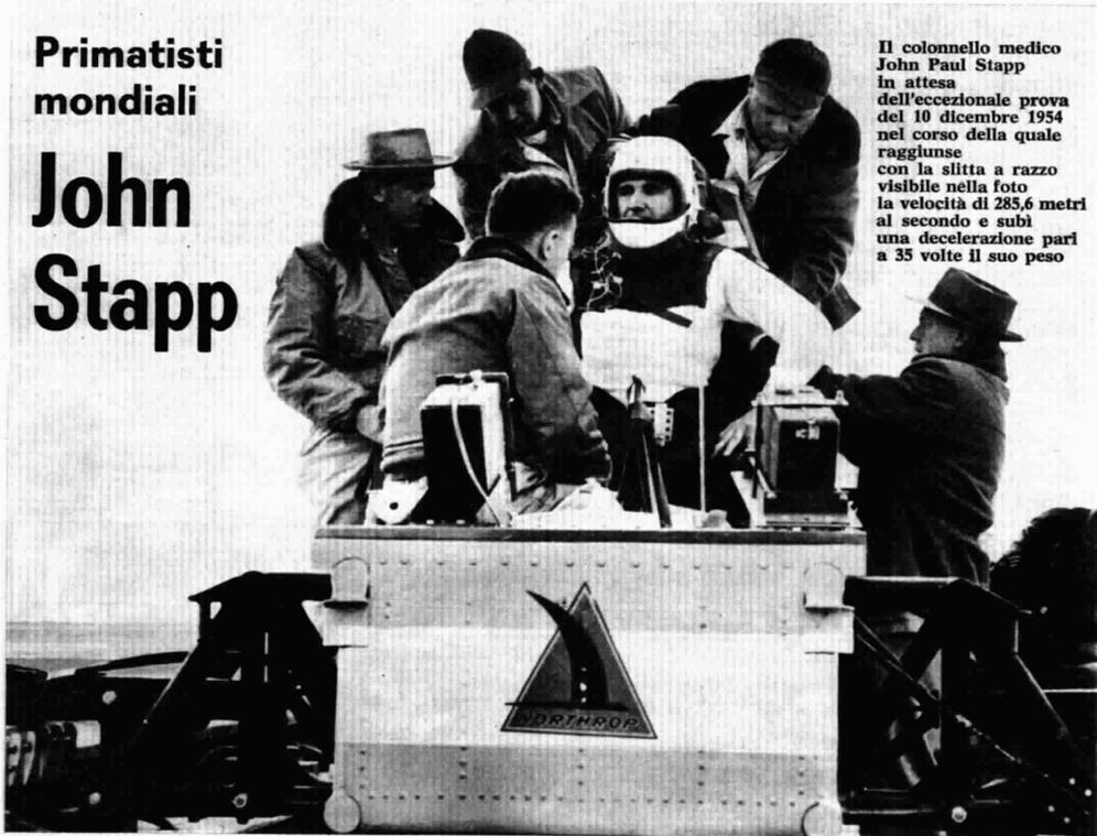
**Il colonnello medico John Paul Stapp in attesa dell'eccezionale prova del 10 dicembre 1954 nel corso della quale raggiunse con la slitta a razzo visibile nella foto la velocità di 285,6 metri al secondo e subì una decelerazione pari a 35 volte il suo peso**
