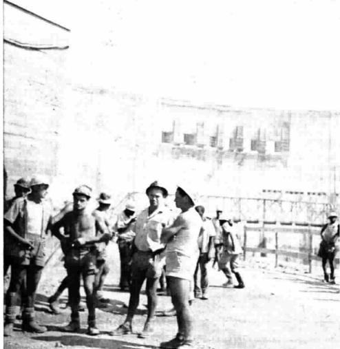
Un gruppo di lavoratori italiani di fronte alla diga di Kariba, in Rhodesia. Questo gigantesco e funzionale impianto è frutto dell'opera dei nostri tecnici e dei nostri operai
