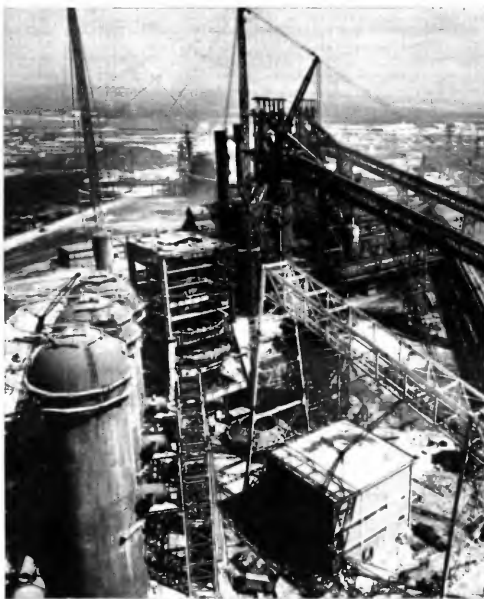
Il nuovo altoforno n. 3, in via di costruzione a Taranto nel quadro dei lavori di ampliamento del Centro siderurgico
