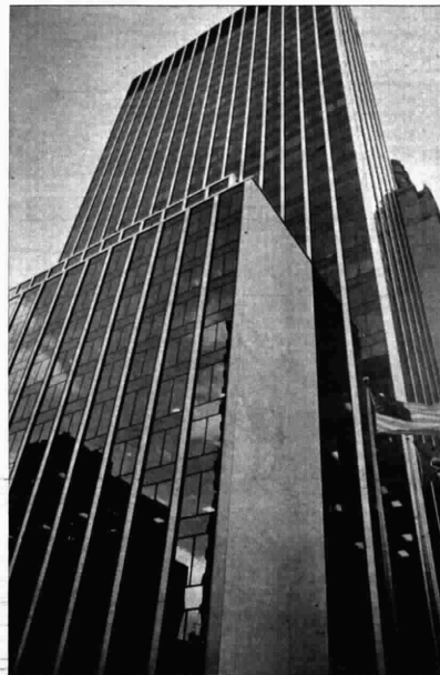
Il grattacielo dove ha sede l'ufficio di corrispondenza della Radiotelevisione Italiana a New York. Padrona di casa è la RAI Corporation, una società affiliata alla RAI
