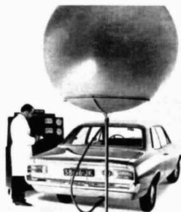
Prima dell'uso di Chevron con F-310. Questa automobile, usata normalmente, è stata selezionata per il suo motore particolarmente sporco, onde sottoporre Chevron con F-310 alla piú difficile delle prove. A motore acceso, è stato collegato al tubo di scappamento un pallone trasparente. Il pallone ha cominciato a gonfiarsi di gas inquinanti fino a diventare così scuro da impedire che si vedesse il marchio Chevron posto dietro il pallone.
