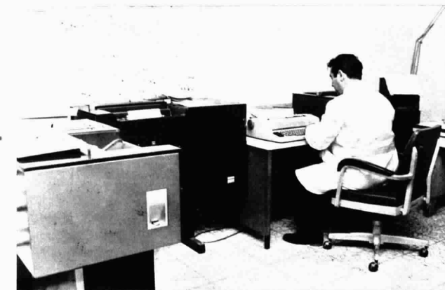
Uno dei sedici terminali elettronici attraverso i quali le questure possono collegarsi ventiquattro ore su ventiquattro con l'archivio di Roma per l'aggiornamento o la richiesta di dati. L'unità stampatrice è in grado di battere 14 caratteri al secondo
