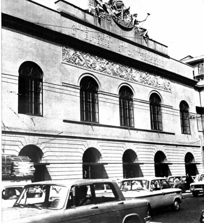
Il Teatro Argentina di Roma. Rimesso a nuovo, potrebbe diventare la sede dello Stabile in via di ricostituzione
