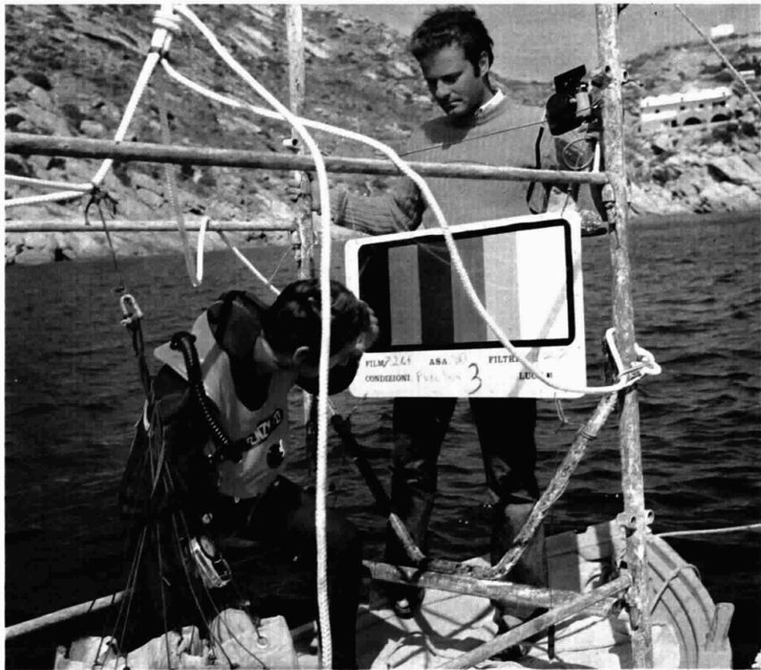
Preparativi per l'immersione. Le lampade illuminanti, la tabella « campione-colore », le batterie sono state montate su un traliccio di tubi di ferro assicurato con un cavo ad un verricello sul battello-appoggio. In questo modo sarà meno laborioso traslocare il complesso dell'attrezzatura da un fondale all'altro
