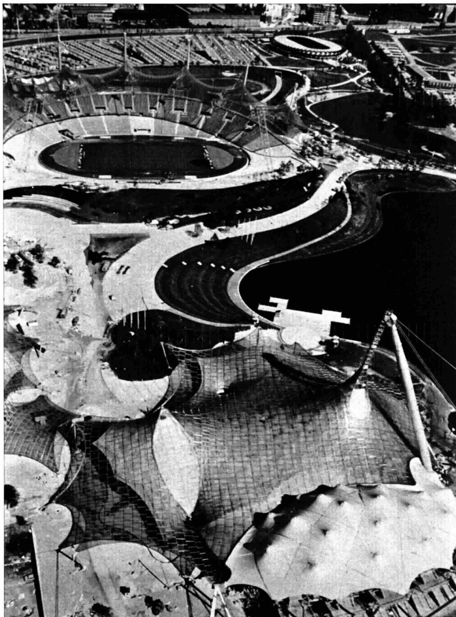
Visto così sembra leggerissimo: un velo trasparente gonfiato dal vento. In realtà il «favoloso tendone» pesa oltre 1600 tonnellate ed è retto da un complicato sistema di cavi (lunghezza complessiva quattrocento chilometri)
