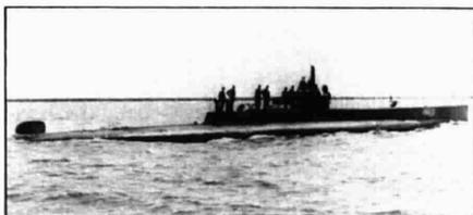
Il sommergibile «Nereide» in navigazione di superficie. Il suo dislocamento era di 225 tonnellate, la velocità, in emersione, di circa 13 miglia, di 8 in immersione. L'equipaggio era composto di due ufficiali e 17 tra sottufficiali e marinai. Era armato di due siluri in tubi di lancio fissi e di uno brandeggiabile. Costruito dal regio arsenale di Venezia, queste erano le sue misure: lunghezza metri 40,96; larghezza metri 4,30. Profondità massima raggiungibile: 40 metri
