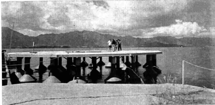
Parte di modello in scala della piattaforma su cui sorgerà una città galleggiante giapponese
