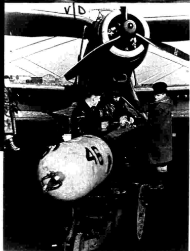
L'aerostirante, un'arma che decise molti scontri sul mare. Nella foto sopra, una nave colpita a morte sta per imbarcarsi. Nel '44 i tedeschi utilizzarono in combattimento anche aerei a reazione
