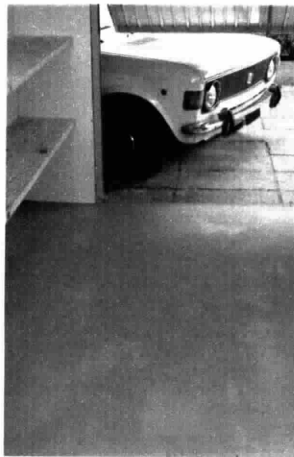
1 febbraio 1979, ore 9: Il pavimento in cemento del tuo garage è nuovo. Per ora tutto bene...
