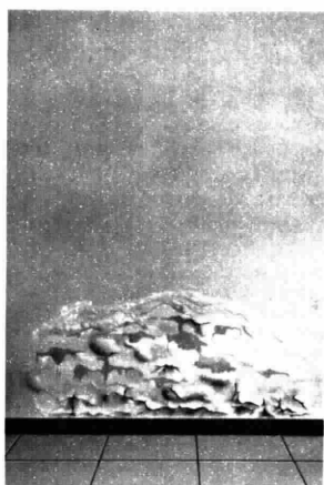
15 Febbraio 1977: I sali presenti nella muratura, per effetto dell'umidità, danno luogo a efflorescenze. Si formano delle bolle, la pittura si stacca, l'intonaco si gonfia e si scrosta...
