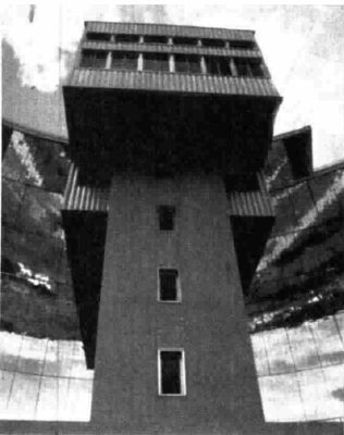
La centrale solare di Odeillo col gigantesco «forno»: 63 specchi, 3800 gradi al centro, 1000 kilowatt di potenza
